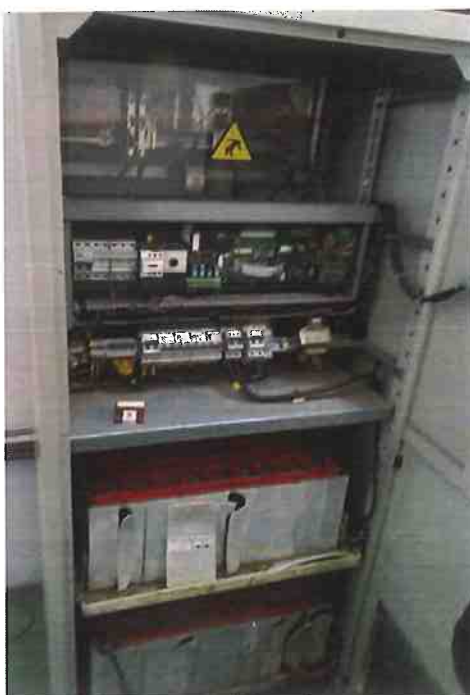
Figure 1 : vue des composantes du chargeur de batteries
